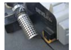
Lassen van gemodificeerd bitumen
